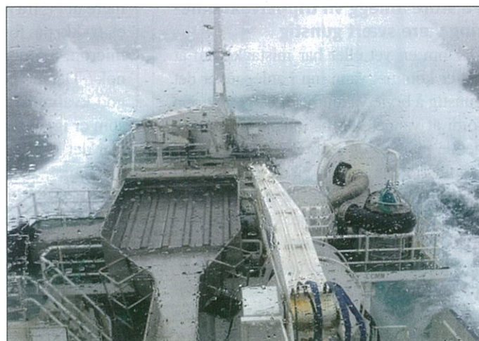
Kjøle- og fryseanleggene må arbeide i et tøft miljø med sjøsprøyt, skaking og risting i all slags vær.
